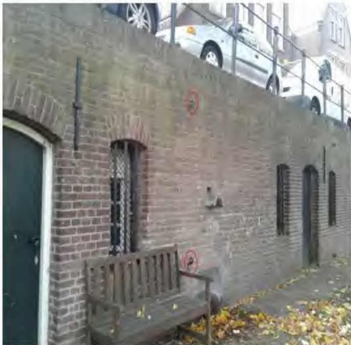
Figuur 4: Voorbeeldfoto positie prisma's (rood omcirkeld)
